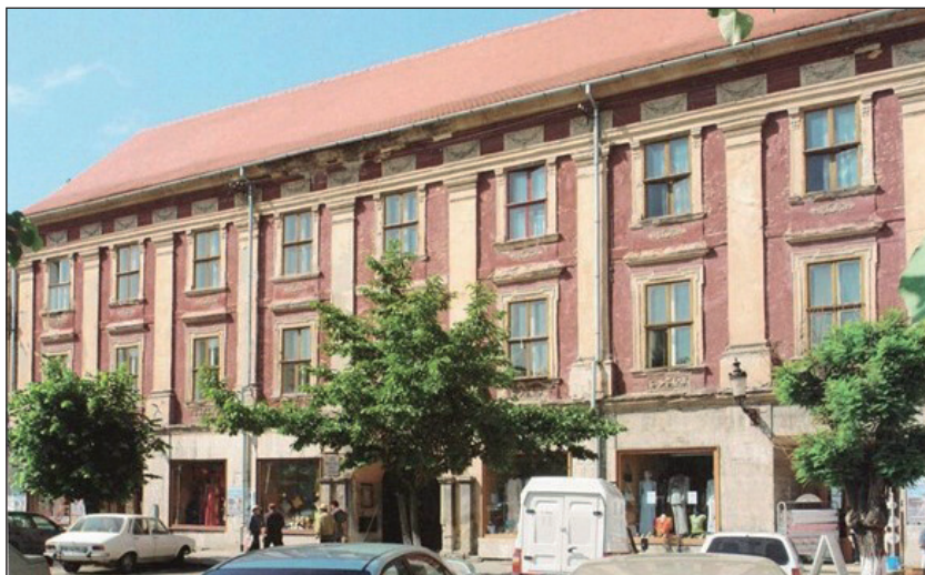
Edificio del antiguo colegio de Medgyes
