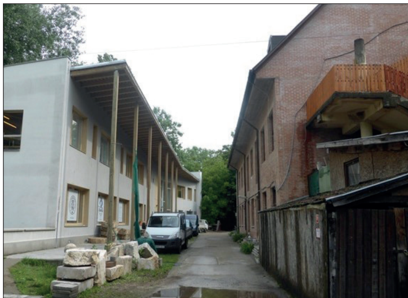
Göd: taller de Carpintería a la izquierda; de albañilería a la derecha
