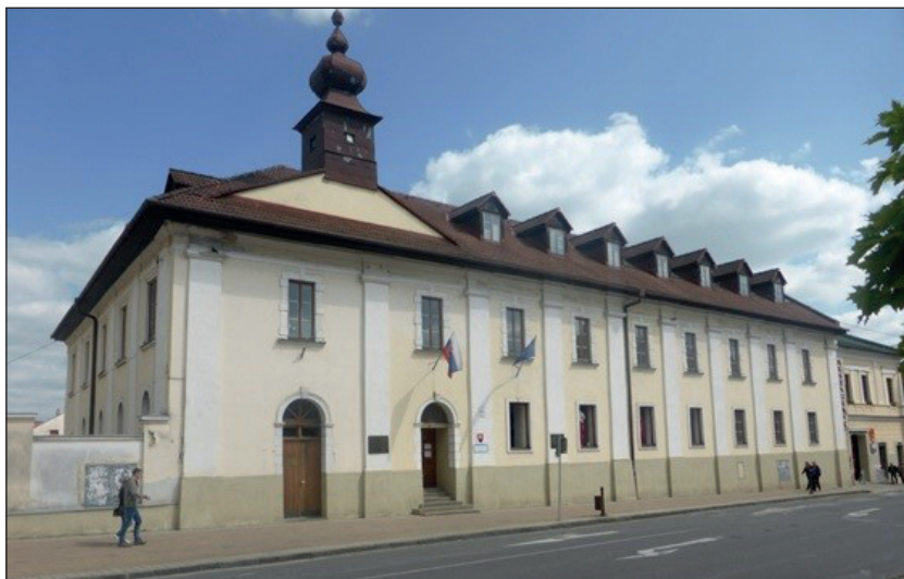
Antiguo edificio escolapio en Brezno; iglesia y colegio convertido en sede del Ayuntamiento
